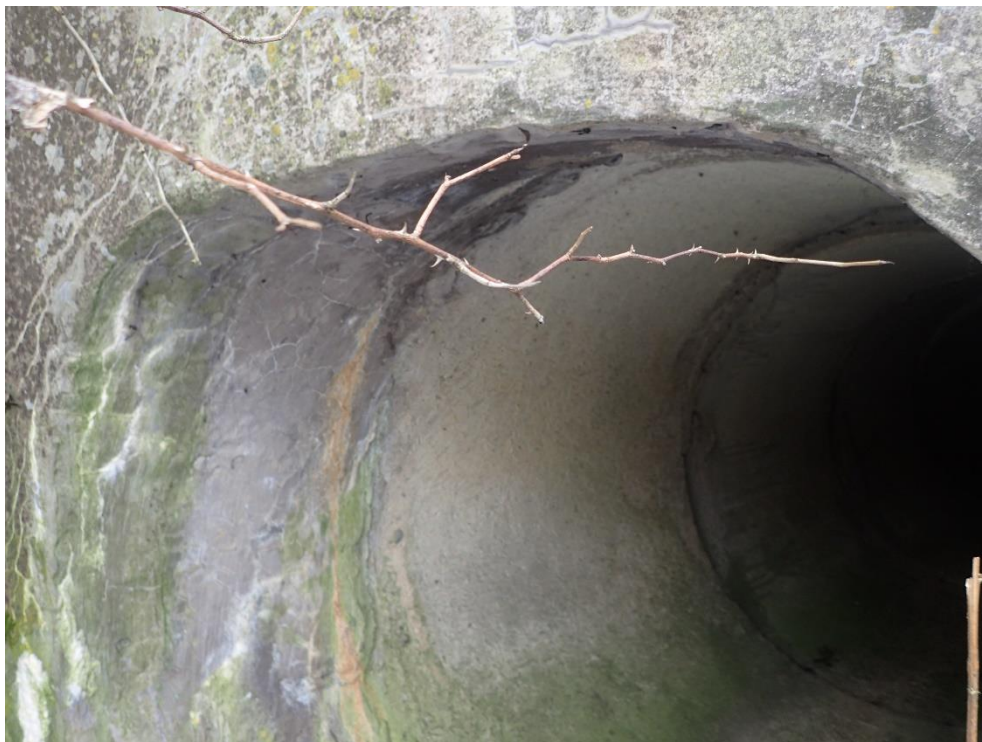
Foto 3: Výluhy a praskliny v troubě propustku
